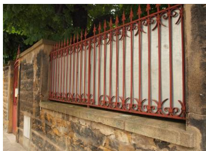
clôture en fer forgé à conserver
