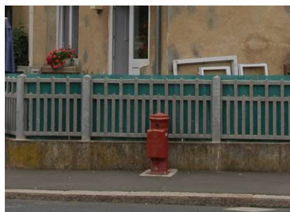
clôture en béton à conserver en S3 (mais sans pare-vue !)
