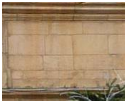
exemple de maçonnerie en pierre de taille destinée à être apparente...
