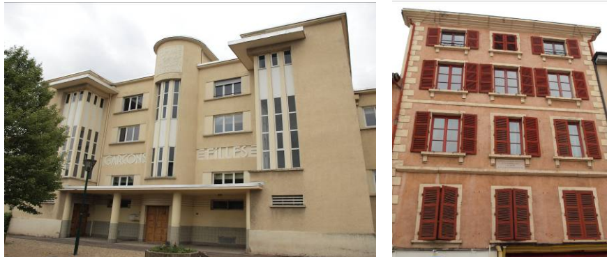
exemples de façades aux menuiseries homogènes et cohérentes
