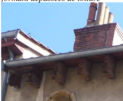
dépassée de toiture à chevrons débordant sculptés
