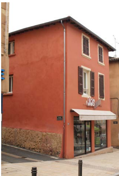
enduit traditionnel à la chaux rue Nationale
