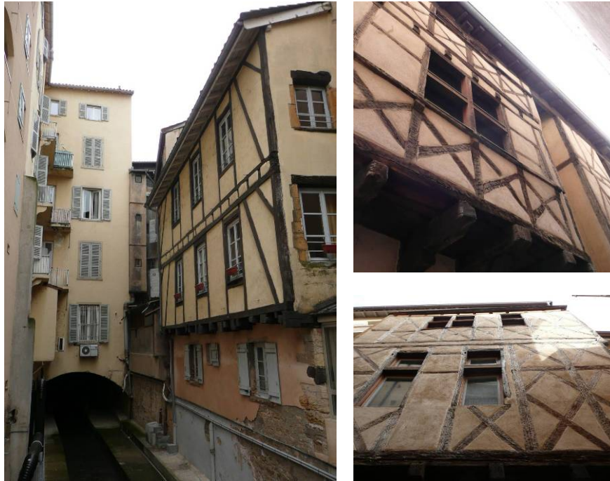
exemples de maisons à pans de bois, principalement le long de la rue Nationale...
