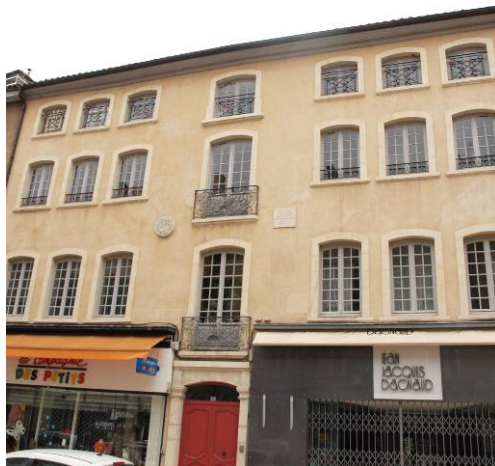
exemple de façade composée : la maison de Madame Rolland de type classique...
